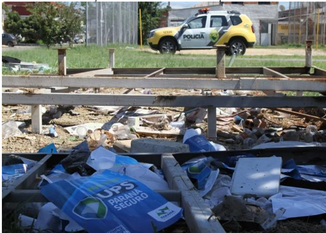
Figura 26 – estrutura de sustentação do contêiner e entulhos deixados por uma UPS desativada em Curitiba.
